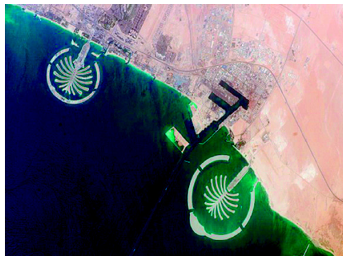
Рис. 113. На насыпных островах около побережья Дубая будут построены фешенебельные отели и бизнес-центры (космический снимок)
